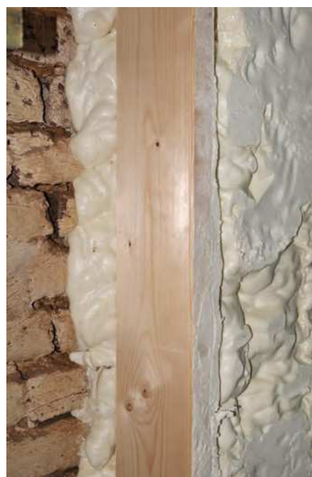
Redukcja mostków termicznych
